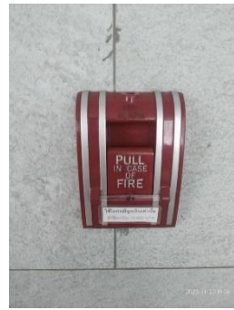
แผงควบคุม (Fire Alarm Control Panel : FCP) Fire Alarm Pull Station
