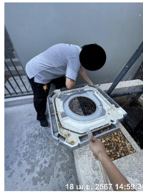
รูปที่ 2-37 ล้างแผ่นกรองและล้างแอร์ส่วนกลาง
