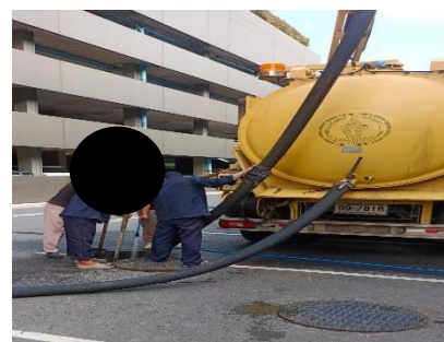
รูปที่ 2-46 สูบตะกอนส่วนเกิน เมื่อวันที่ 13 พฤศจิกายน 2566 ในปี 2567 มีแผนในเดือนสิงหาคม
