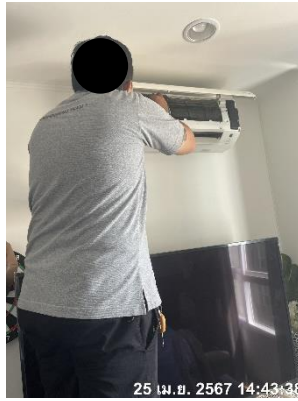
รูปที่ 2-37 ล้างแผ่นกรองและล้างแอร์ส่วนกลาง
